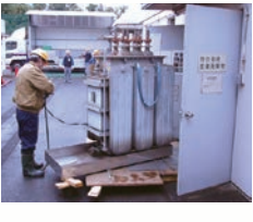
PCB機器の搬出・運搬・処理 搬出不可機器に係るPCB分析 設置場所におけるPCB簡易分析 低濃度PCBトランスの洗浄処理
