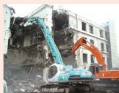
アスベスト調査・ 除去工事、 建築物・ 施設解体撤去工事
