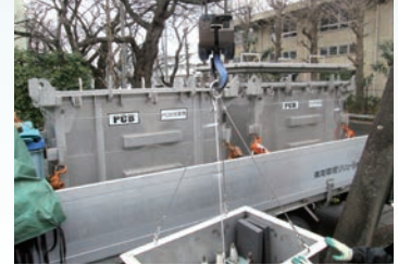
PCB収集運搬の状況
