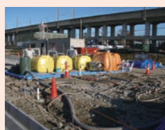
土壌汚染・ 地下水汚染調査対策/ 浄化工事/ モニタリング
