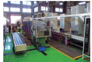
冷蔵庫前処理ラインの外観
