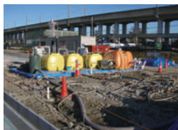
土壌汚染・ 地下水汚染調査対策/ 浄化工事/ モニタリング
