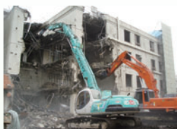
アスベスト調査・ 除去工事、 建築物・ 施設解体撤去工事
