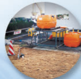
地下水汚染対策調査 ・浄化工事 ・モニタリング
