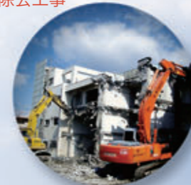
建築物・施設解体 撤去工事
