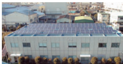
入舟事業所設置の 20 kw 太陽光発電システム
