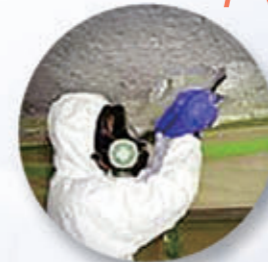
アスベスト調査 除去工事
