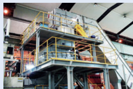
本格稼動した冷蔵庫一次破碎機
